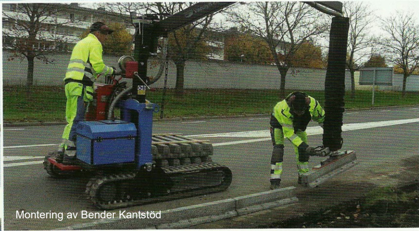
Montering av Bender Kantstöd
